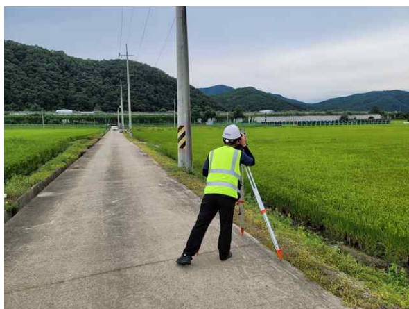
광파기를 이용한 측량 작업
